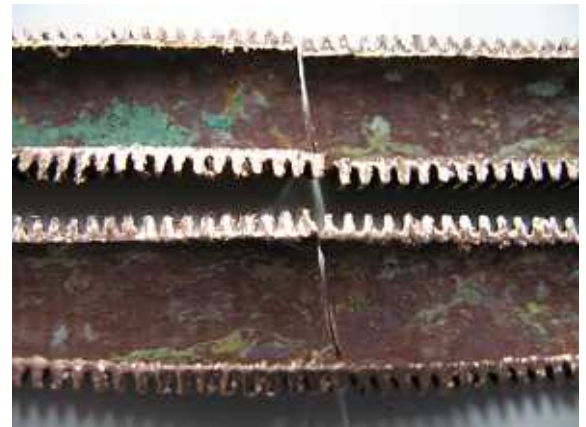
06 銅管内面(1)洩れ部
