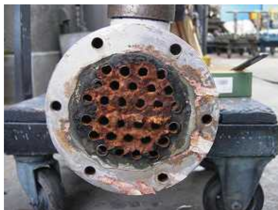
06 管板面洗浄(ボンネットB)
