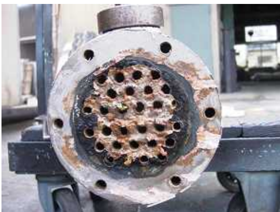
03 管板面(ボンネットB)
