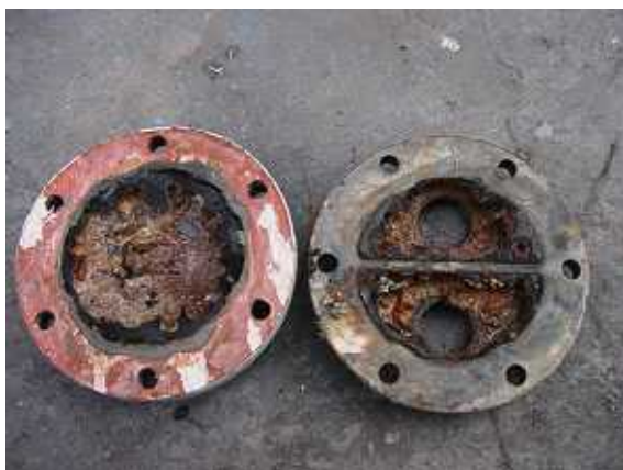
04 ボンネット内面
