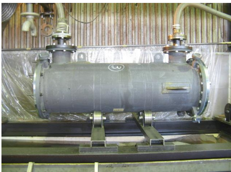
フラッシング 油を循環させ、熱交換器 内の浮錆付属物、残留 異物などの除去をはか る。
