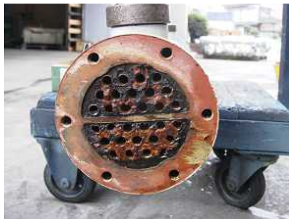
05 管板面洗浄(ボンネットA)
