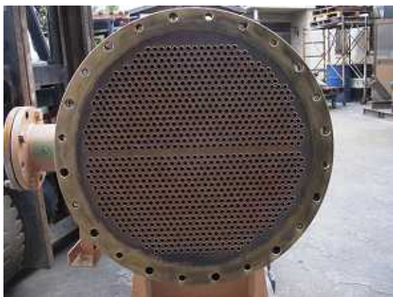
04 管板面清掃完了
